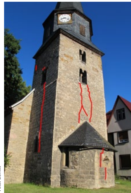
Mit Rot markierte Risse im Kirchturm Windischholzhausen
